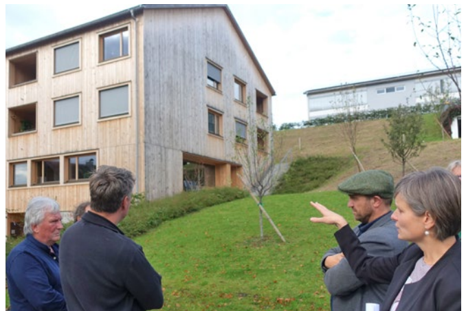
Hittisau, Wohnprojekt Lindohus, Bauherr: Vorarlberger gemeinnützige Wohnungsbau- und Siedlungsgesellschaft m.b.H., Architekt: Bernardo Bader, Führung durch Bürgermeisterin Annette Sohler. Betreutes und Starter-Wohnen mitten im Ort nahe zu identitätsstiftenden Bauten (Kirche und Pfarrhaus) und der öffentlichen Versorgung.
