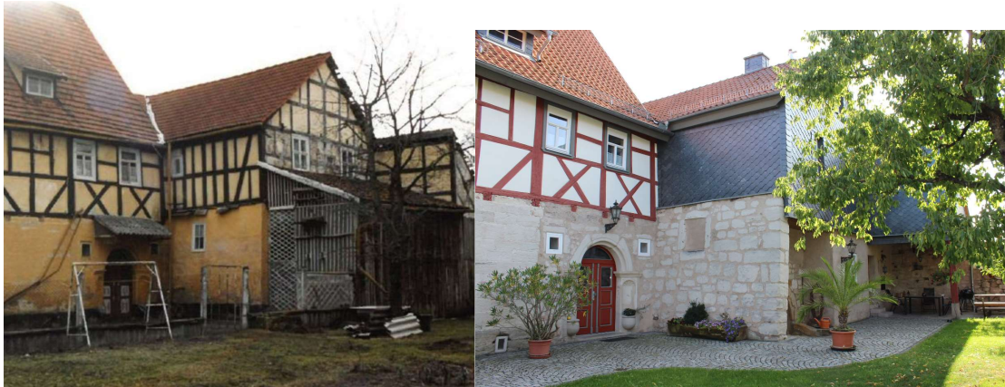
Bildunterschrift: Haus Hunstock in Heldburg (Sanierung) – links vor – rechts nach der Sanierung. Bildautor: Michael Hunstock
