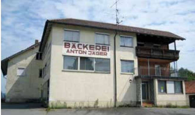
Zustand vor Sanierung
