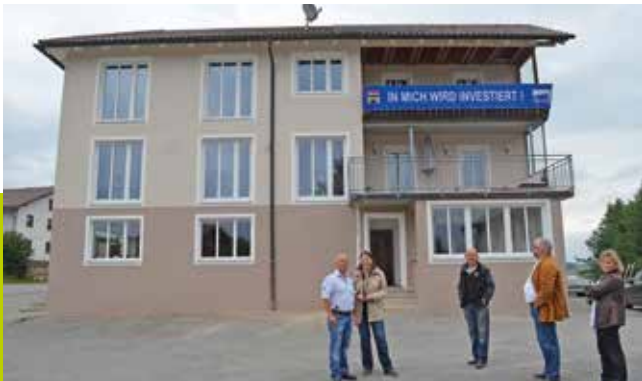
Zustand nach Sanierung
