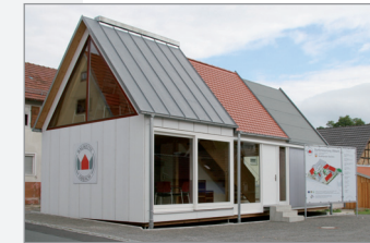
Fertigstellung der Bauhütte
